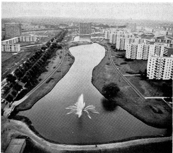
Abb. 6 bis 8. Bremen, Stadtteil «Neue Vahr», Hochhaus von Aalto und Blick von diesem auf Wohnquartier und Grünanlage.
